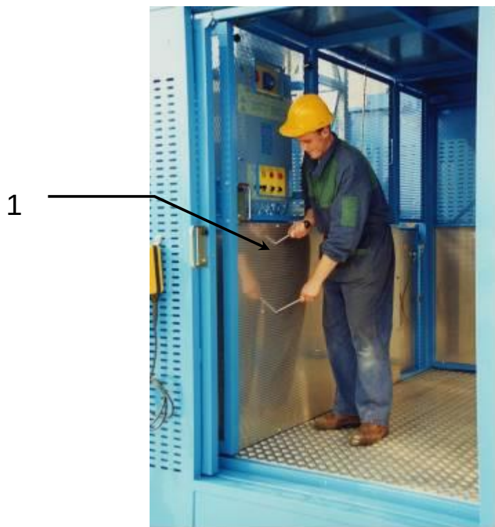
Afb. 5 – Handmatig lichtten motorremmen
