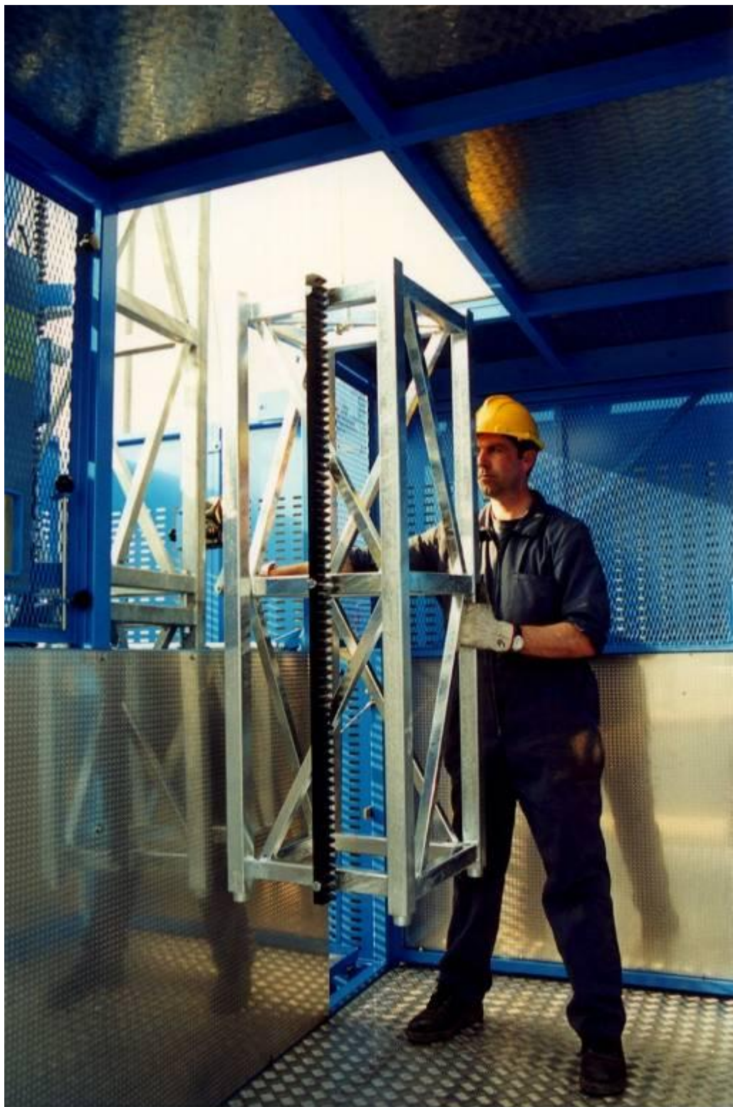
Afb. 19 – Opstellen van de mast
