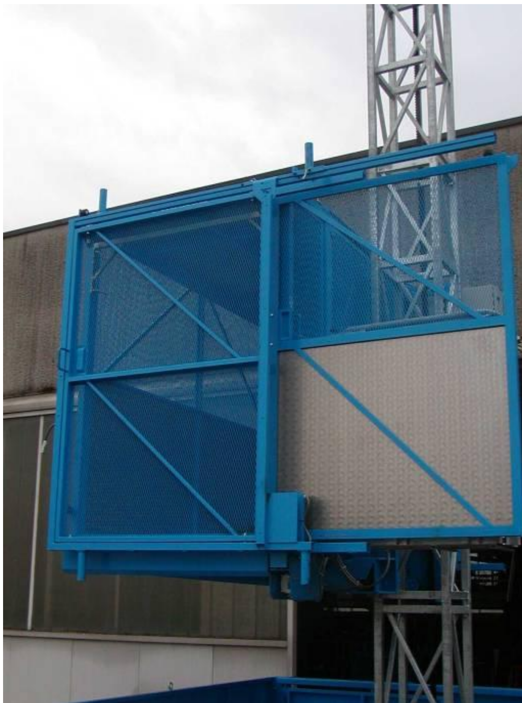
Afb. 22 – Installatie etagedeur
